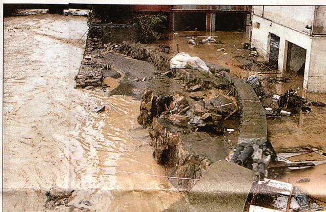
L'argine travolto dalla corrente del fiume. L'acqua ha invaso garage e scantinati provocando la tragedia
